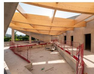
Le gros-œuvre s'est terminé à la fin de l'été, le bâtiment a désormais sa forme extérieure finale. La pose des charpentes bois est en cours de finalisation. En parallèle, les bassins inox ont été livrés en kit sur le site, leur montage va démarrer en octobre en même temps que la pose des structures des châssis vitrés.
