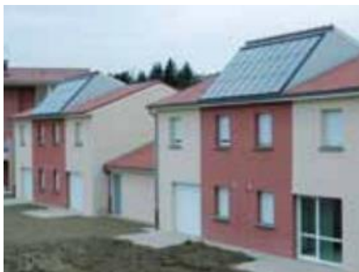
> Couverture totale en capteurs solaires thermiques (Chauffage)
