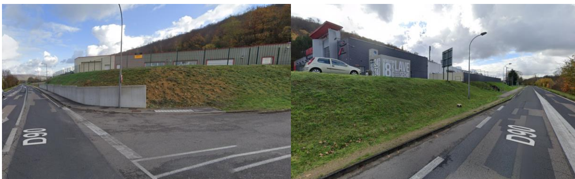
Vues des constructions vis-à-vis de la Route de Frouard (Source : Google)
