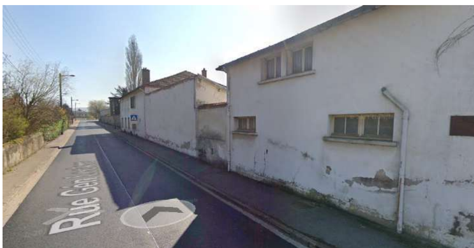
Vue sur les bâtiments qui constituent l'enceinte depuis la rue du Général Leclerc (source : streetview)
