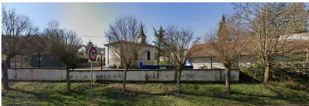
Vue sur l'ilot Pasteur depuis la rue Saint-Pierre (source : streetview)
