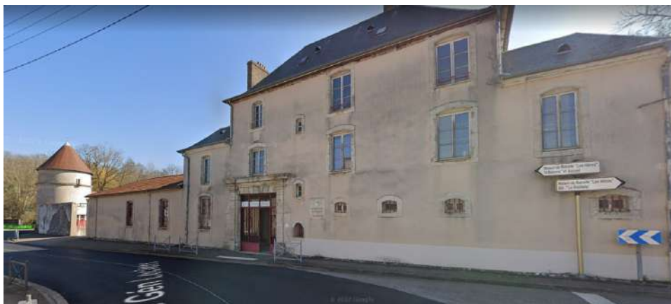
Vue sur le bâti remarquable identifié au PLUi-HD (pièce 5.1.3 du PLUi-HD en vigueur) constitué par la tour médiévale et le Château (source : streetview)
