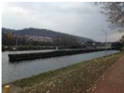
Ecluse de Pompey
