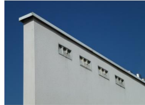
Nichoirs intégrés dans un bâtiment dans le quartier de la Barberie
